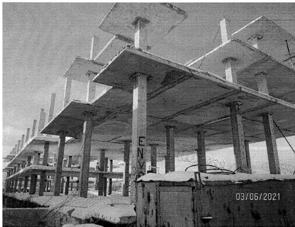
Фото 1. Фрагмент каркаса здания
