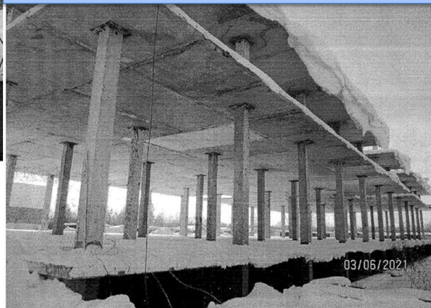
Фото 2. Фрагмент каркаса здания
