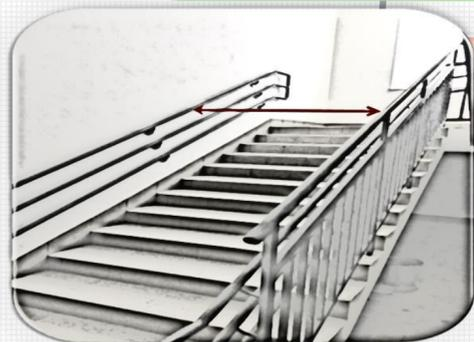
Ширина лестничного марша - расстояние между ограждениями лестницы, между стеной и ограждением лестницы (если ограждение лестницы выносится за пределы ступени, то отсчет ведется от края ступени).
